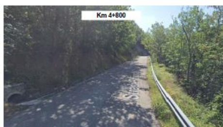
Dissesti del manto diffusi e più marcati in corrispondenza della corsia di valle
