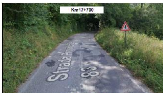
Dissesti del manto e regimazione delle acque non funzionale
