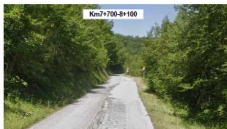
Dissesti del manto e Cedimenti localizzati della scarpata di valle - presenza di tre ordini di gabbioni al termine del cedimento
